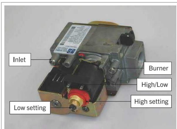
Figure 21 - Composants majeurs de la vanne de gaz des aérothermes TR10 à TR50
